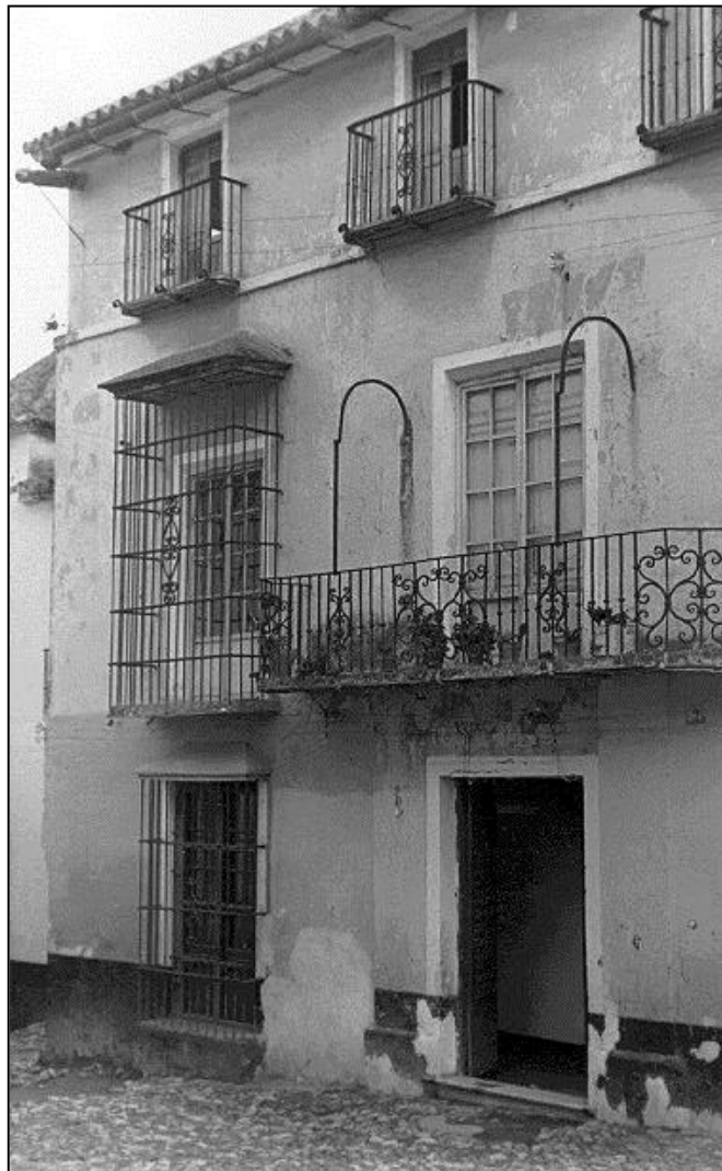
Casa nº 2 de la plazuela de Altamirano, 1948. Fotografía: Fernández Casamayor, Legado Temboury.
